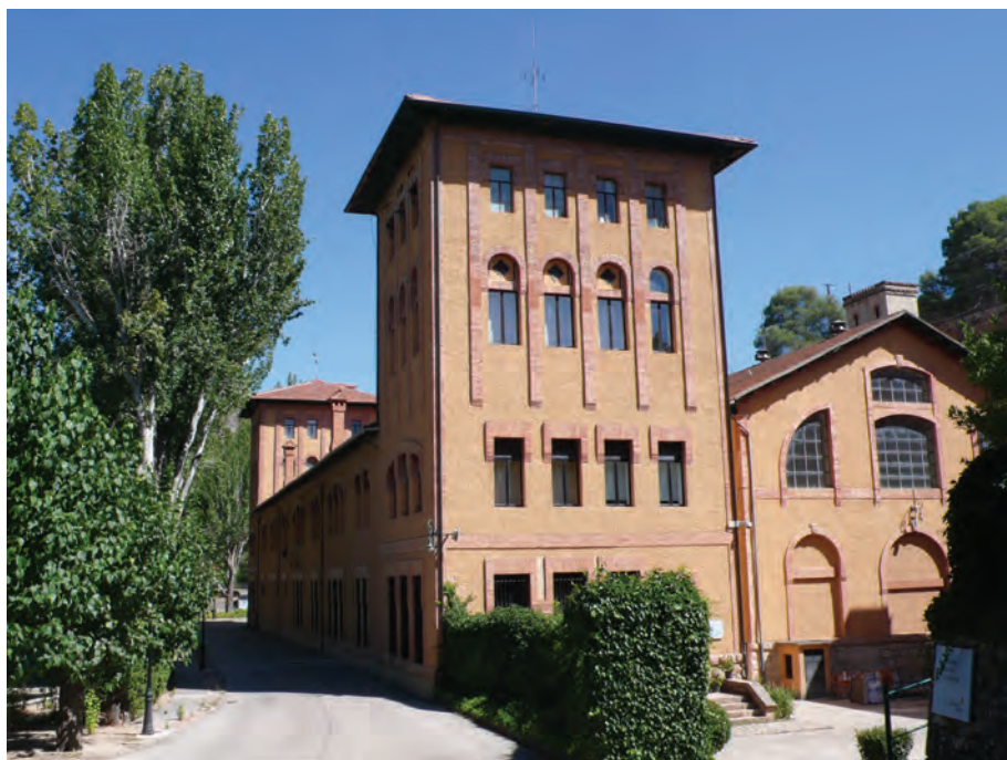
Figura 6. Central de Bolarque, en el Tajo. Fuente: Fotografía del autor.
